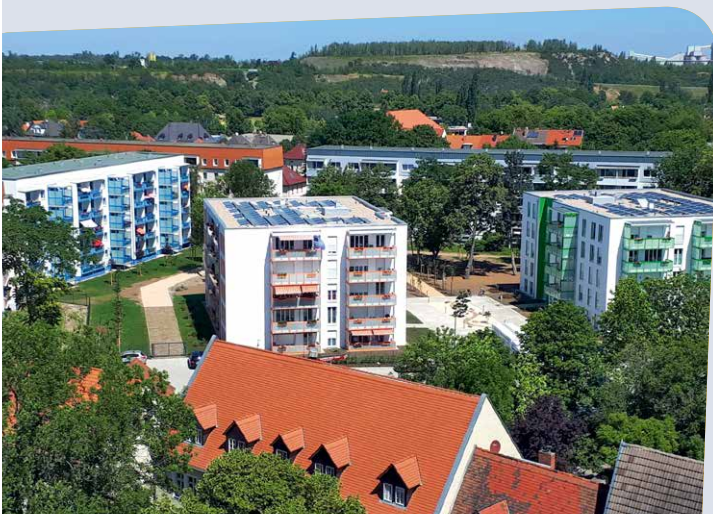
PV-Anlagen auf den Gebäuden Turmweg 4 und 5
