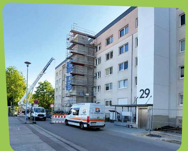
Die Besonderheit bei unseren Aufzugsanbauten besteht darin, dass durch den kompletten Austausch des Treppenhauses ein direkter Zugang vom Aufzug zur Wohnungstür gegeben ist.
